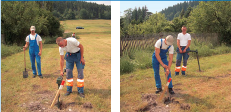
Abb. 5/6: Sondieren und Freilegen
