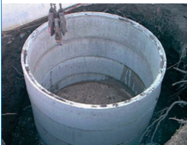
Sicherung der Grabenwände mit nicht-ferromagnetischen Verbau
